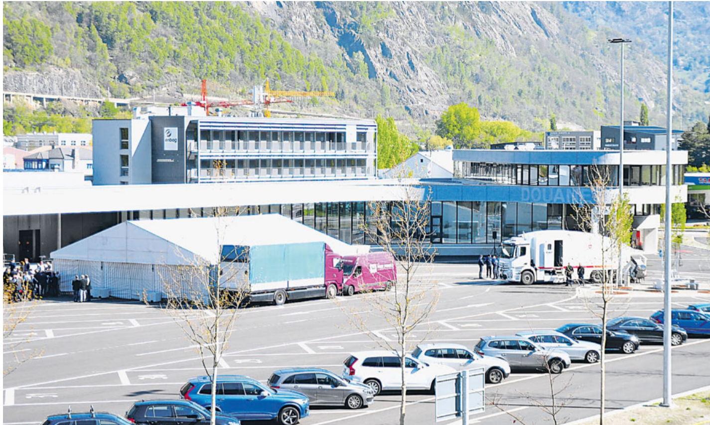
Markante Erscheinung. Das dreigeschossige Gebäude wurde gestern von Pfarrer Daniel Rotzer gesegnet.
