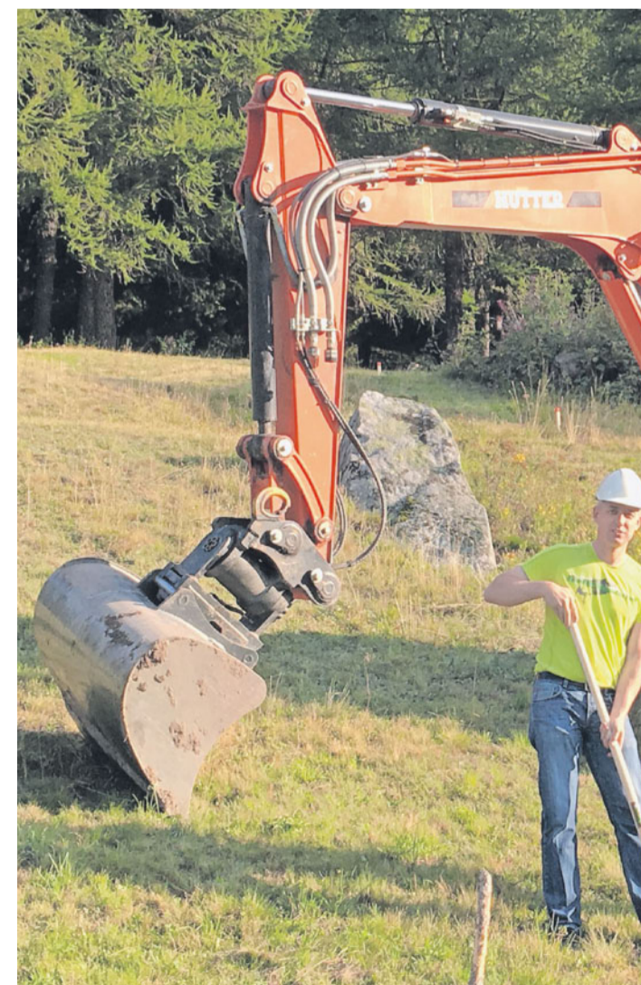
Spatenstich erfolgt. Am Freitagmorgen fiel der Startschuss zum
