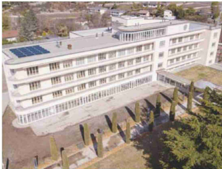
Après quatre ans de travaux, la résidence Plantzette accueillera ses premiers pensionnaires le 23 mars.
