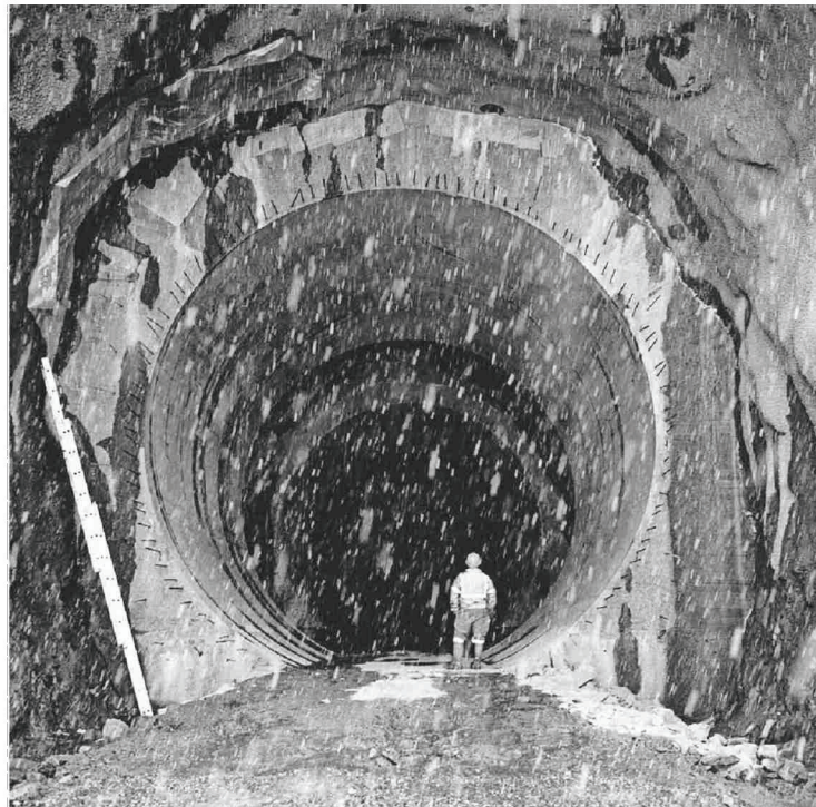
Ein Bild von Tausenden. Wasserfassung der Nant de Drance des Stausees von Emosson.
